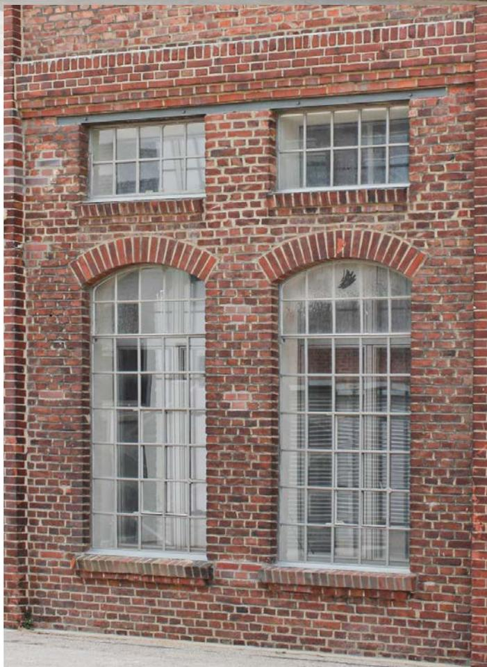
Gelungene Kombination aus historischem Bestand und moderner Fenstertechnik: Hinter die einfach verglasten Original-Sprossenfenster des Erdgeschosses wurden neue Fensterelemente gesetzt.
