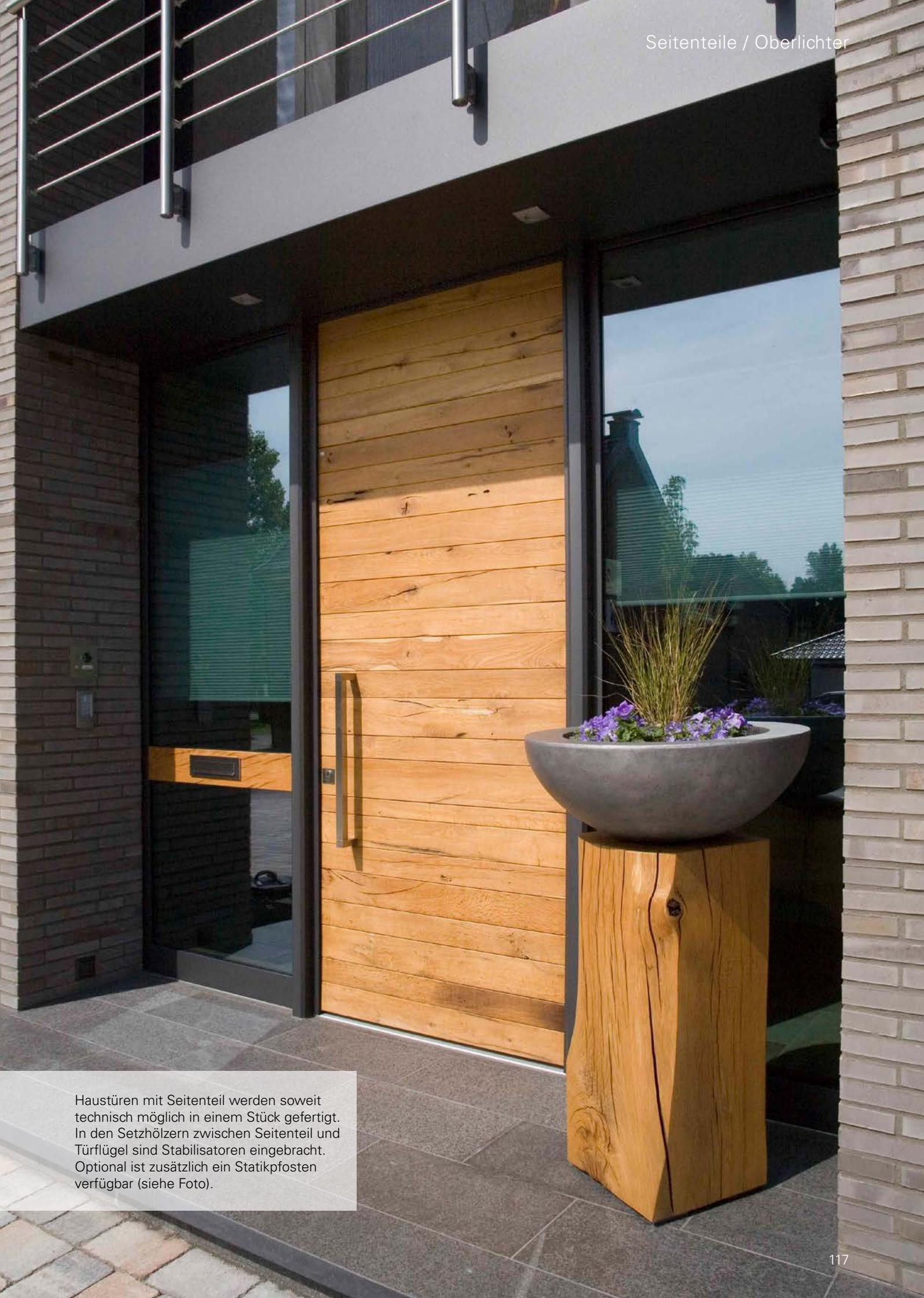
Haustüren mit Seitenteil werden soweit technisch möglich in einem Stück gefertigt. In den Setzhölzern zwischen Seitenteil und Türflügel sind Stabilisatoren eingebracht. Optional ist zusätzlich ein Statikpfosten verfügbar (siehe Foto).
